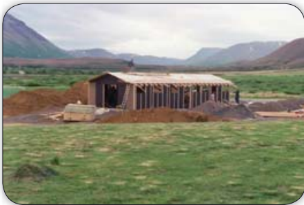
Sundlaugarhús í byggingu.
